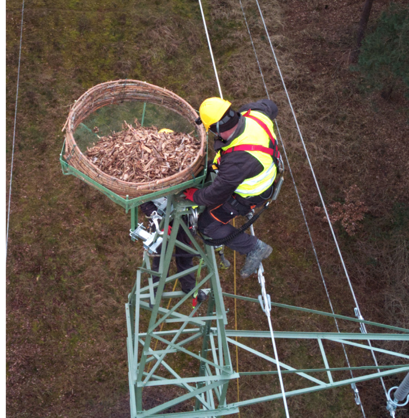
Enea Operator, Montaż platformy pod gniazdo rybołowa
